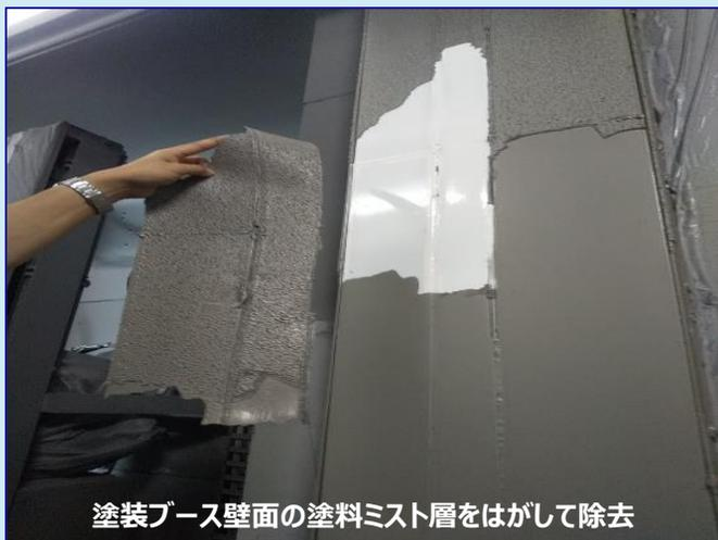
塗装ブース壁面の塗料ミスト層をはがして除去
